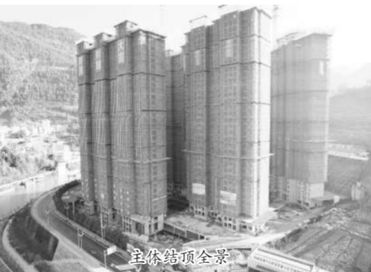
主体封顶全景
