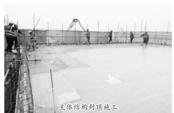
主体结构封顶施工
