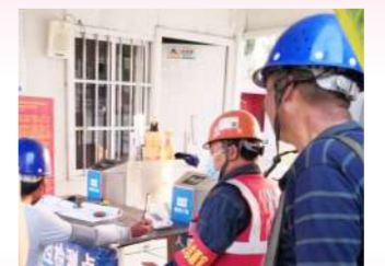
十六分公司洛阳碧桂园二期项目
