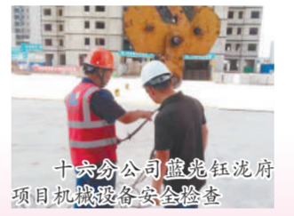
十六分公司蓝光钰沅府项目机械设备安全检查
