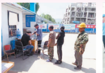
十七分公司正锦水岸6#-11#楼及附属地下车库工程
