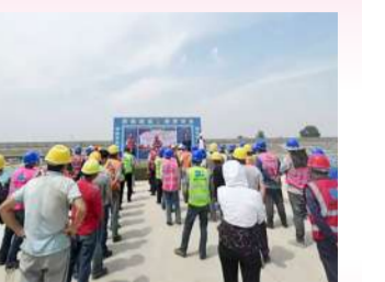
郑州分公司新区污水处理厂二期项目
