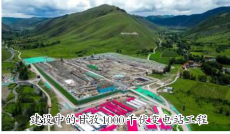
建设中的甘孜1000千伏变电站工程
